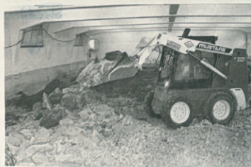
Das «Bagger» hat nur knapp Platz in der niedrigen Halle.
