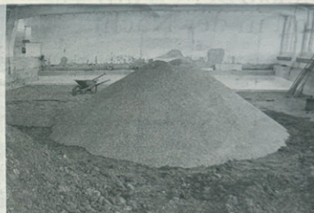
20 Kubik Splitt wurden in der Halle verteilt. Darüber wurden Dämmplatten gelegt.
